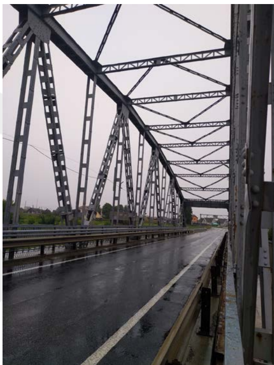
Мост через р.Неман на км 65,774 автодороги Р-41
