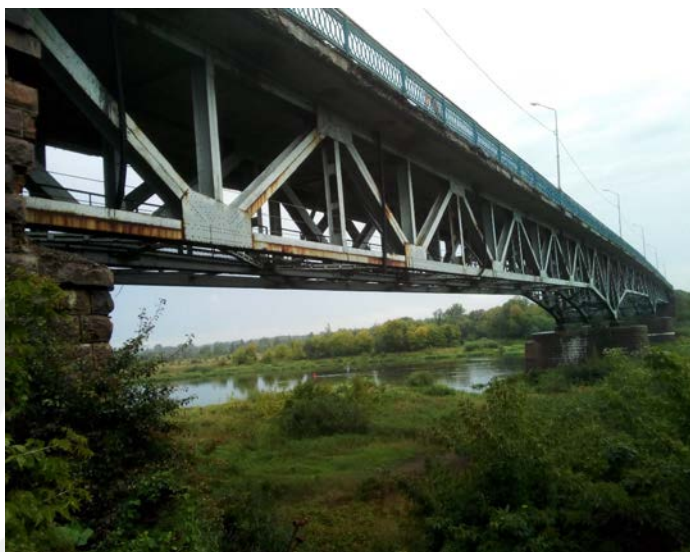
Мостовой переход через р.Березина на км 230,961 автодороги Р-43
