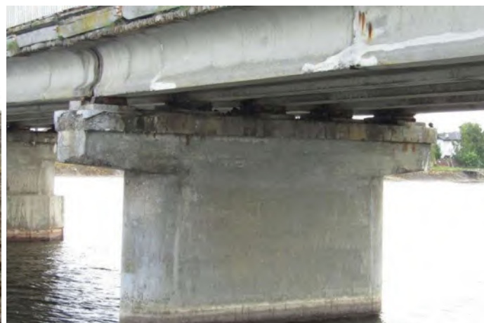
Промежуточная опора №2, фрагмент пролета №1 вид из пролета №1
