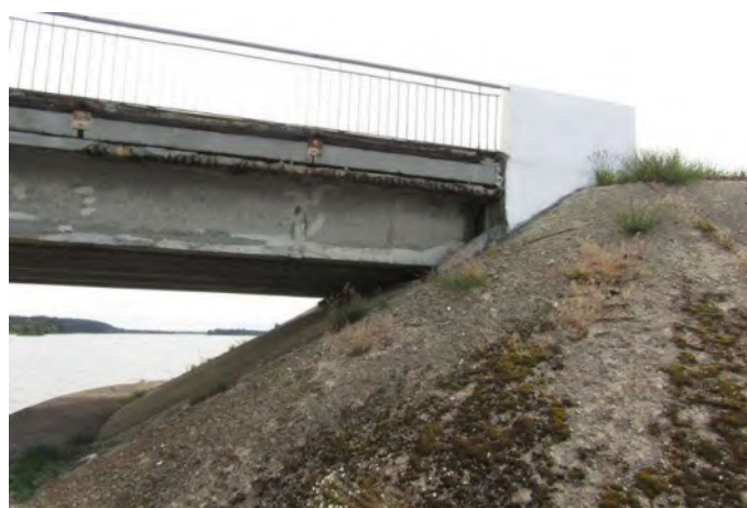
Береговая опора №1, фрагмент конуса №1, фрагмент пролета №1
